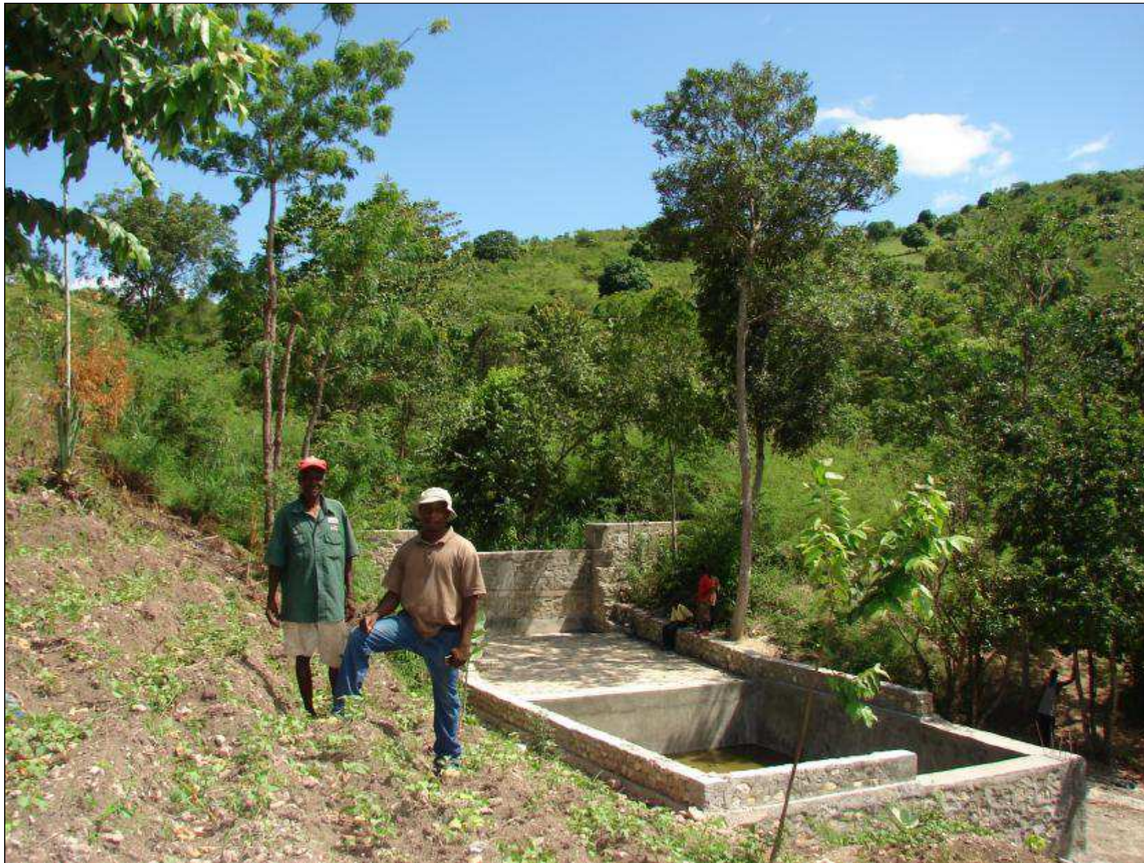
C28 adossé à SB27. Bassin de 80 m 3 d'eau pour arrosage au goutte à goutte. Un début de mise en connexion des bassins (à partir de S26 bis).
