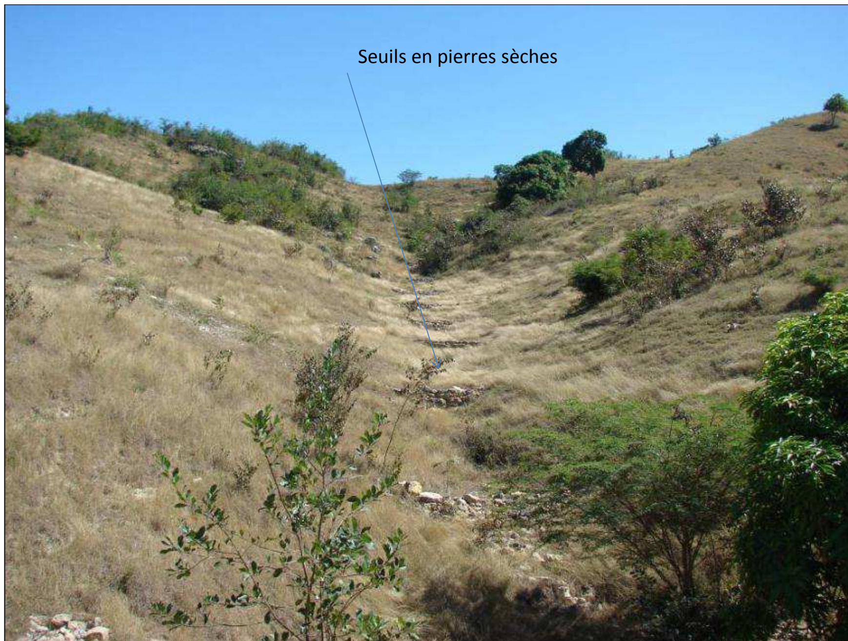
Vestiges de seuils en pierres sèches construits par PADF en 2005 dans le haut de Ti Crête (après le passage du cyclone Jeanne en septembre 2004. Photo du 28 janvier 2009)
