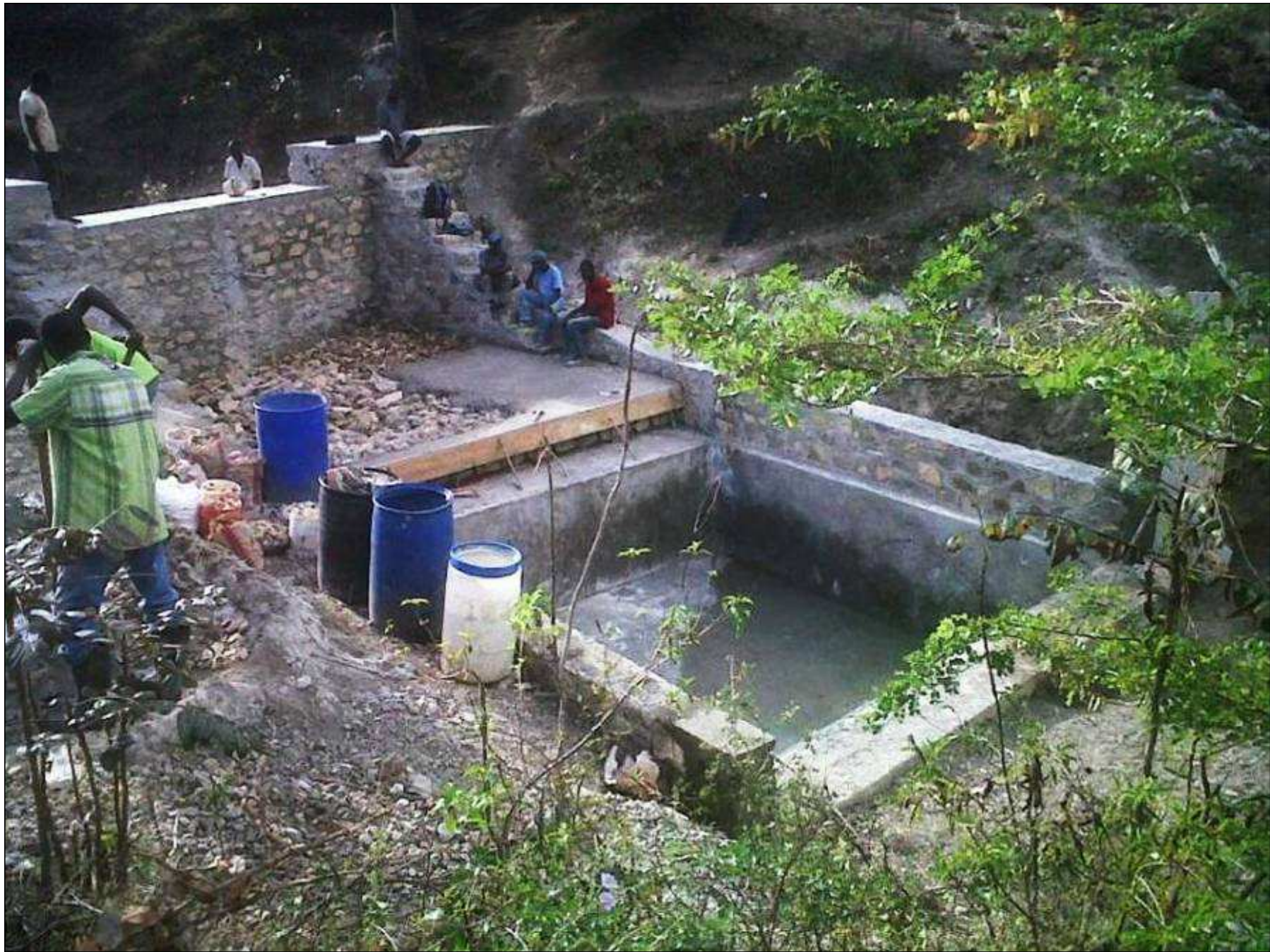
En aval du seuil : contreforts, radier et bassin de dissipation d'énergie et de stockage (40 m 3 )
