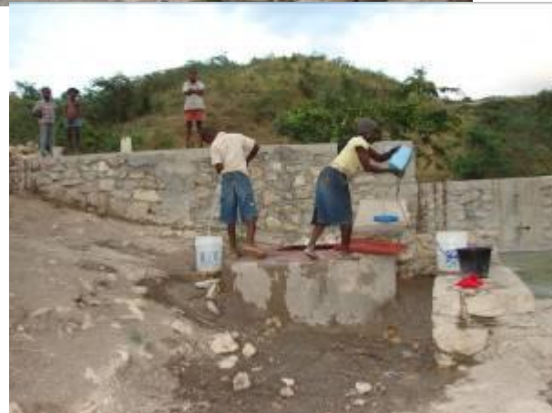
Seuil maçonné S 41 et réfection de puits
