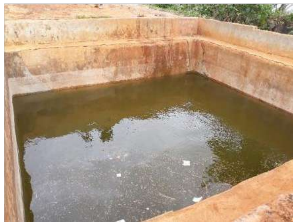
Figure 8 : Essais de réparation sur un des bassins de Platon
