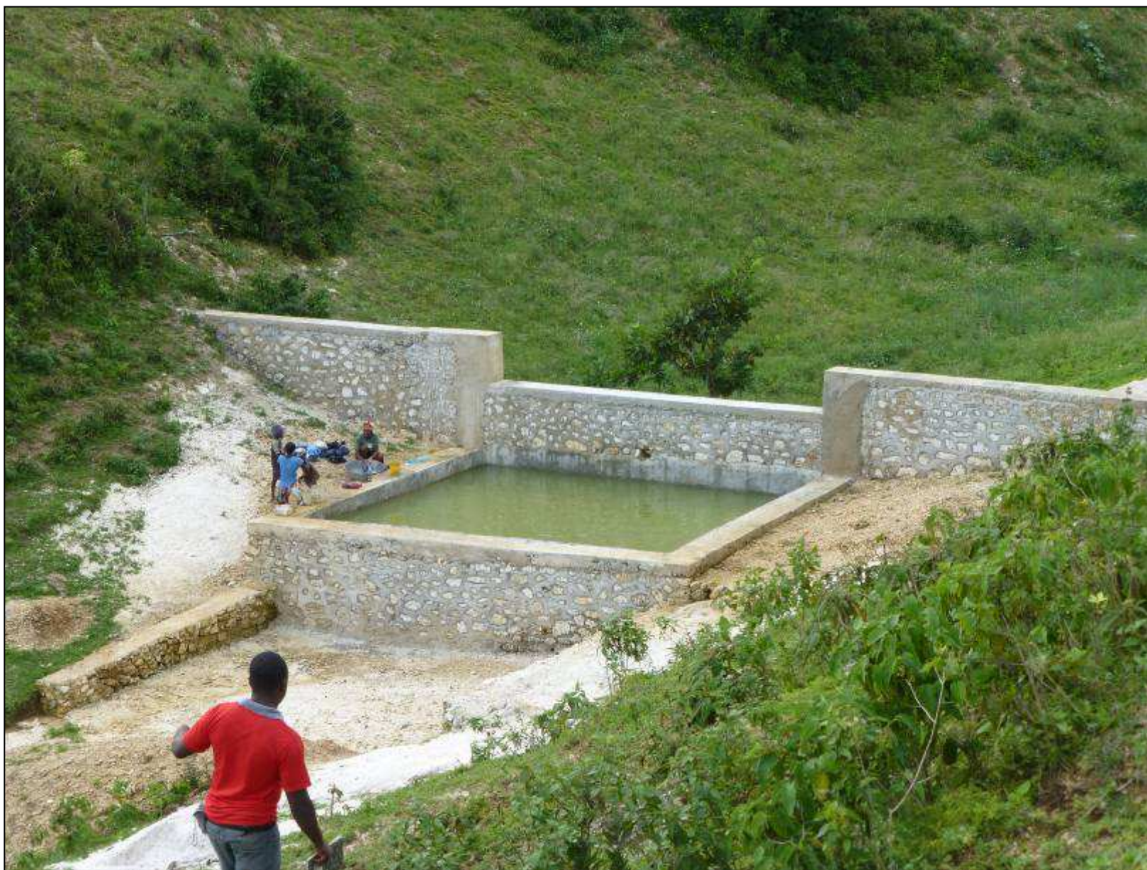
Seuil maçonné et bassin de 72 m 3 en aval
