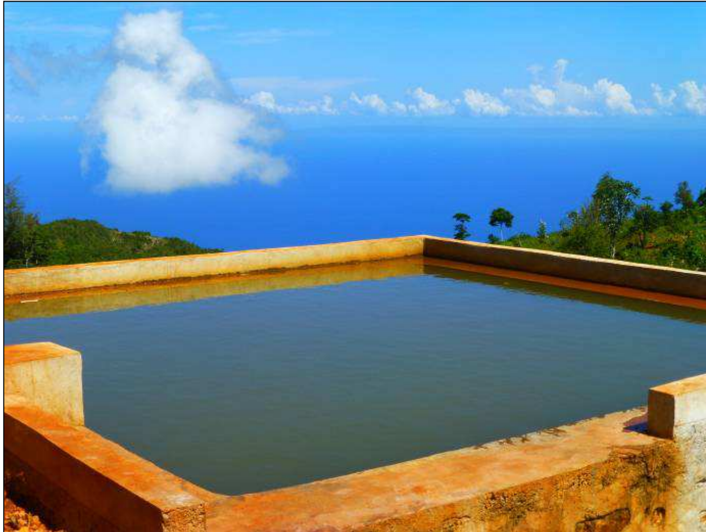
Bassin B9 recueillant les eaux ruisselant sur les bandes de roulement Habitation Catin - 2013
