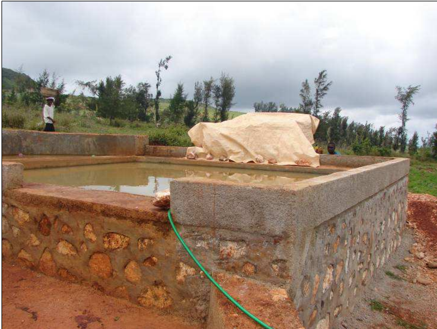
Bassin B5 recueillant les eaux ruisselant sur les bandes de roulement Habitation Catin 2013
