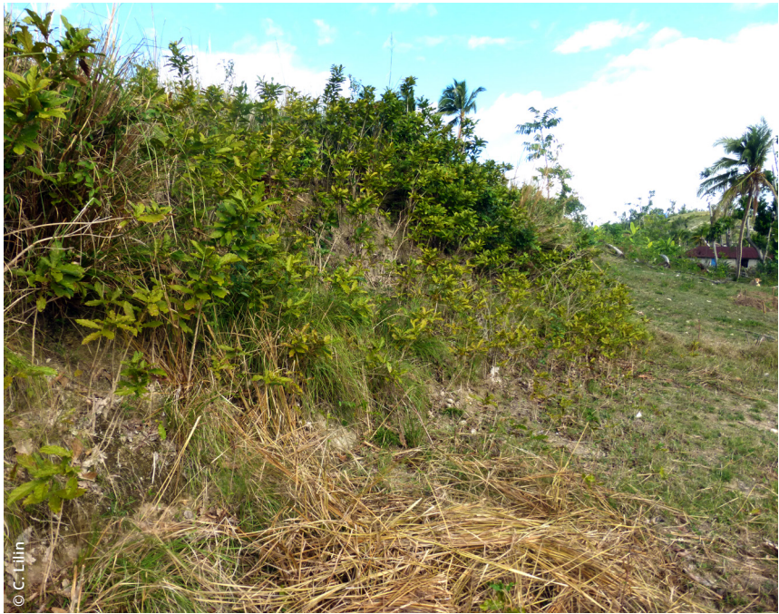
Talus partiellement renforcé.
