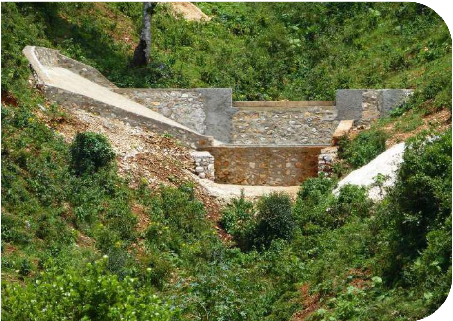
Seuil bassin (SB2) dans la ravine Maurepos (2013). Un glacis latéral a été construit pour récupérer les faibles précipitations en saison sèche.
