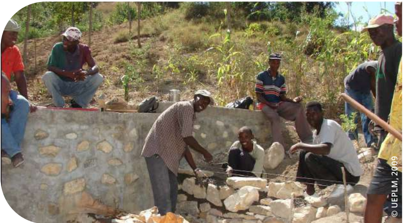
Phase de construction du bassin de dissipation du seuil S2, ravine Ti Crête, Gros-Morne.
