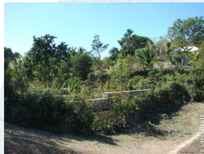
Exemple de complémentarité entre un aménagement biologique et un aménagement en dur : la haie de candelebrine limite l'affouillement du radier du seuil. Ravine Chatelain à Gros-Morne.
