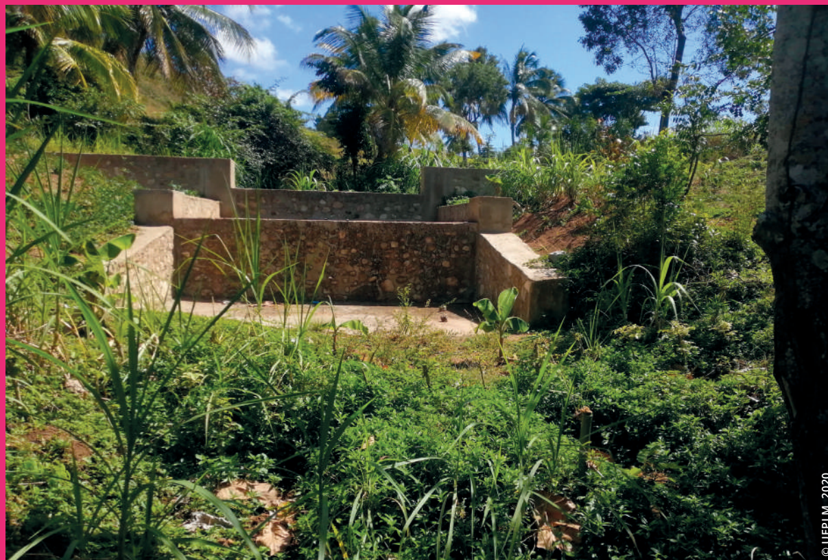
Complémentarité d'un aménagement maçonné et d'une structure biologique (bambou, herbe éléphant, cèdre) via l'installation d'un seuil bassin dans la ravine Kady à Marcabée (Port-Salut).
