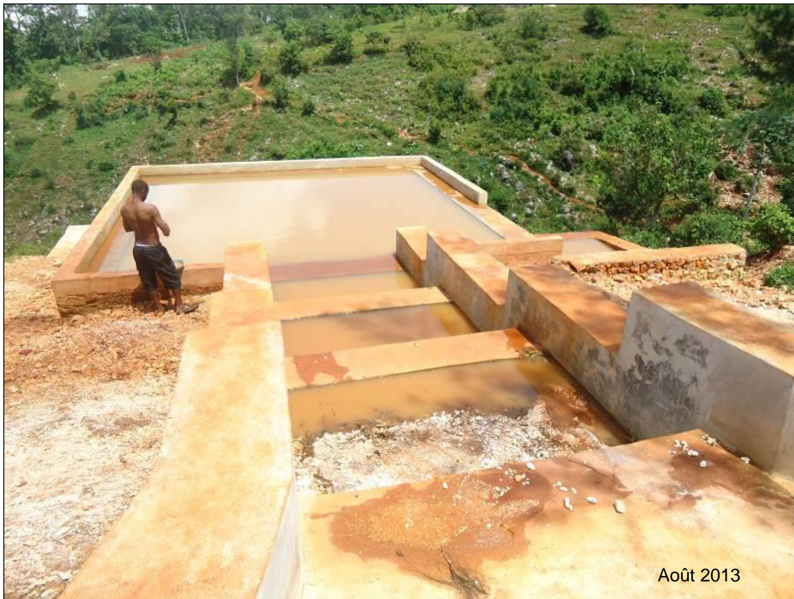
Bassin B8 recueillant l'eau de ruissellement des bandes de roulement et renvoyant le trop-plein dans la ravine Maurepos
