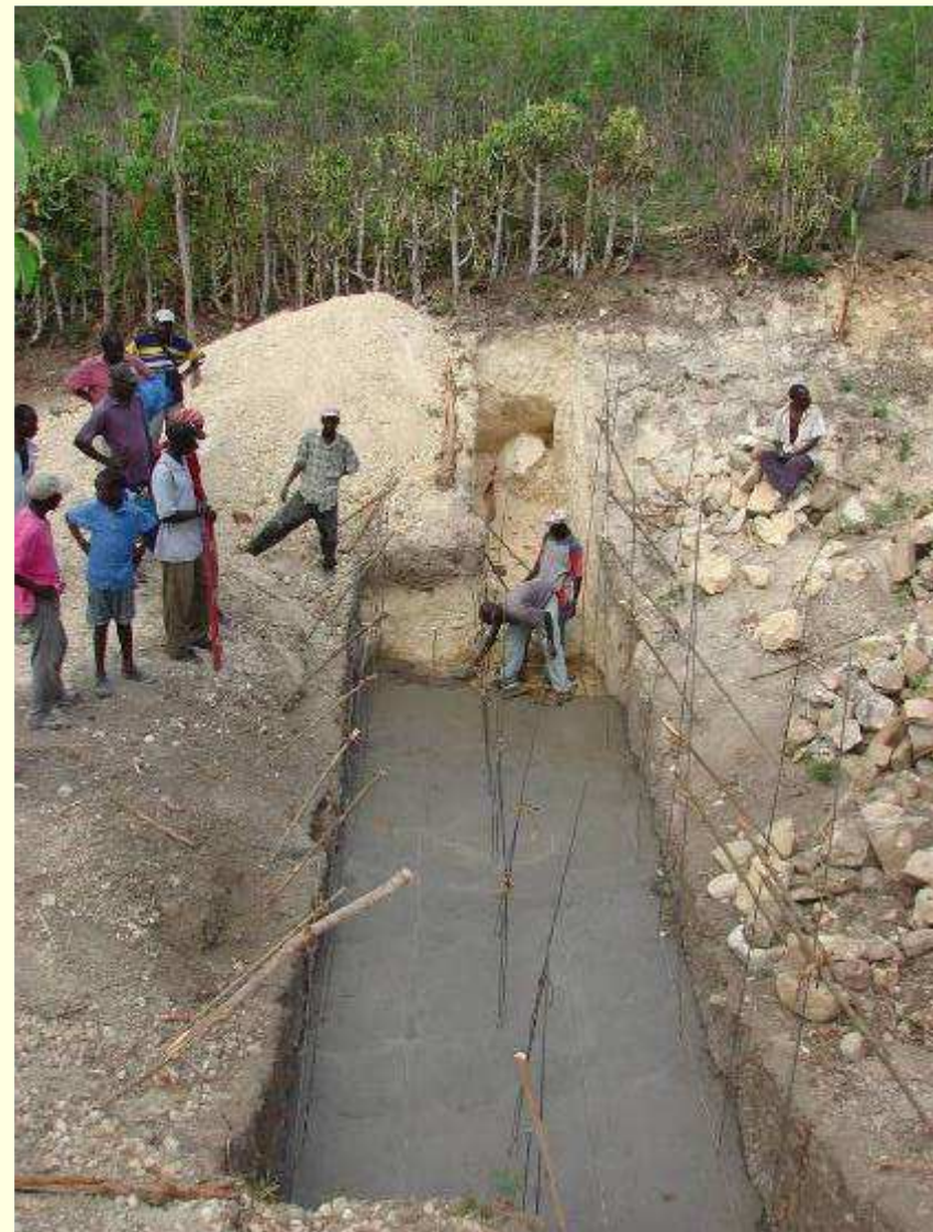
Travaux de fondation pour poser les gabions
